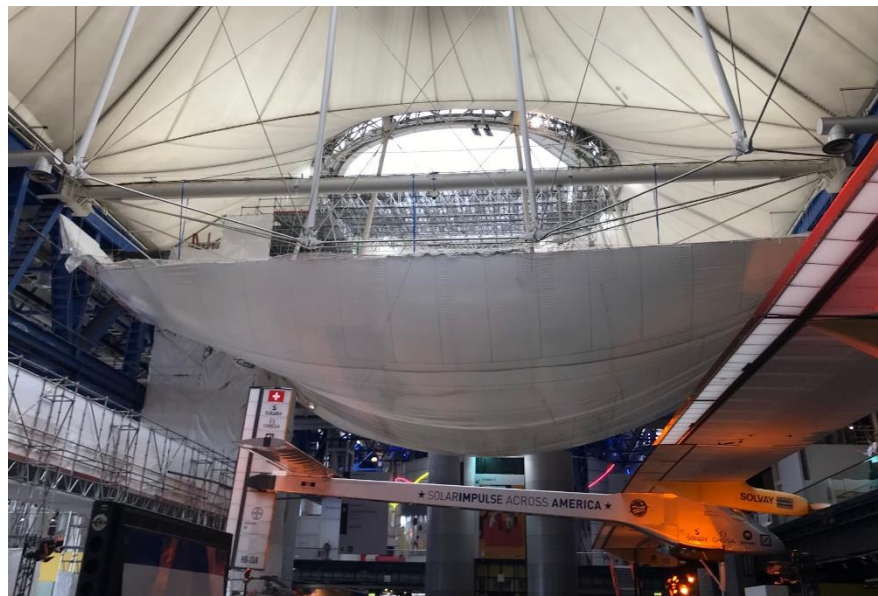
Bâche posée, plateforme suspendue en cours de montage
